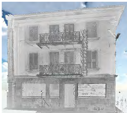
Fassadenaufnahme mit Laserscanning Punktwolke.
