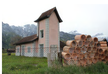
Abb. 3: Pumpstation der Meliorationsgenossenschaft mit Trafostation (Foto MGR).
